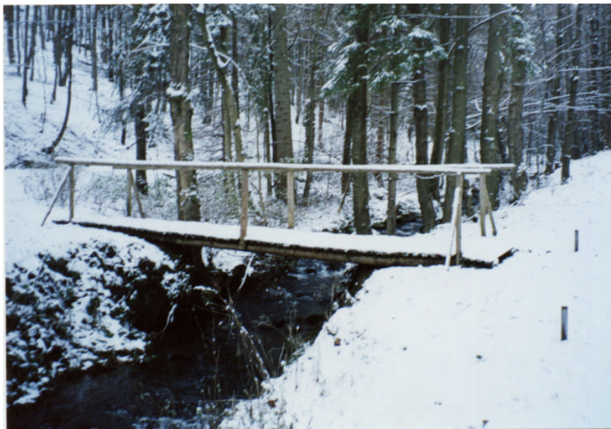
Foto 1: ID 87 , Holzbrücke an Schanzenanlage bei Vesser (Aufn.: Verwaltung BR Vessertal)
