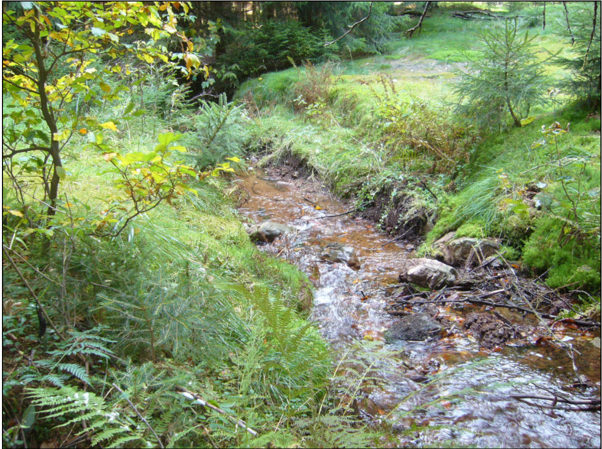
Abbildung 2: Zustand nach Rückbau der Betonrohre (Aufn. J. Erdtmann, 14.10.2009)
