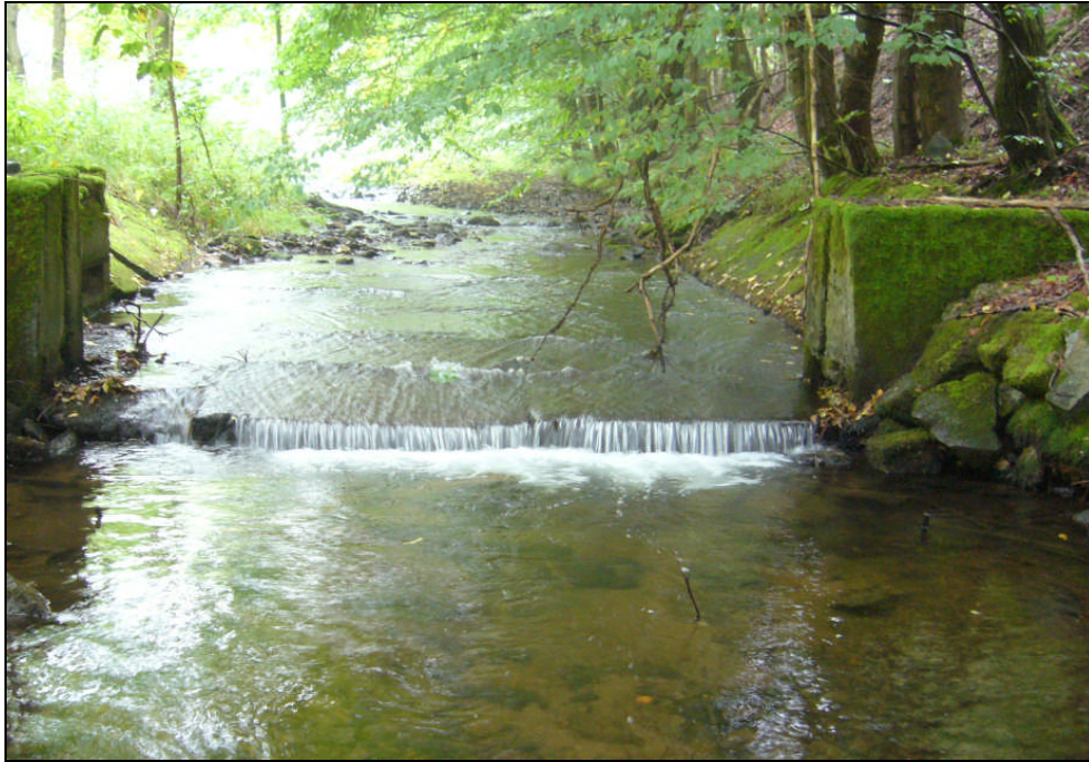
Abbildung 2: Zustand des alten Stauwehrs (Aufn. J. Erdtmann, 02.09.2008)
