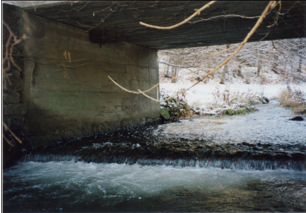
Abbildung 1: Sohlabsturz an der Schneidmühlsbrücke (Aufn. U. Greiner, 15.11.2001)
