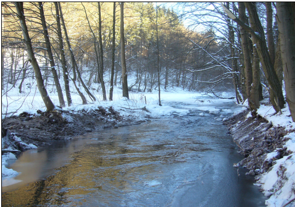
Abbildung 3: Zustand nach Abriss des alten Stauwehrs (Aufn. J. Erdtmann, 09.01.2009)
